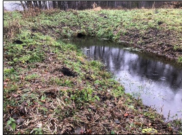
Abb. 5 Gebietsauslass der Kranichwiese mit einem Rohrdurchlass unter dem Forstweg. (19.12.2023)
